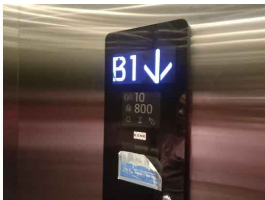
KONE Ecodisc indicator display
